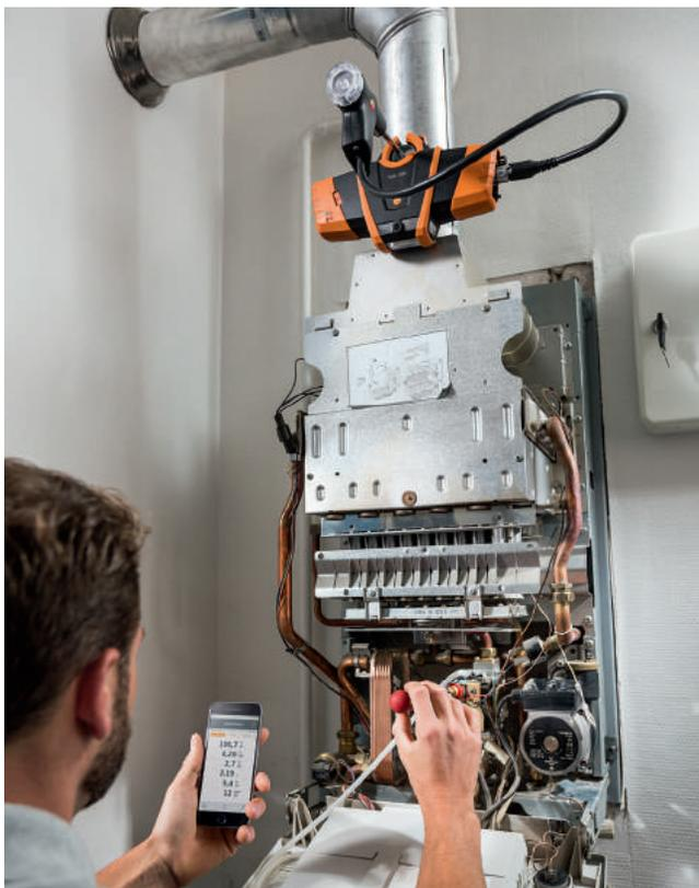
Per le operazioni di regolazione è indispensabile un analizzatore di combustione, come ad es. testo 330i
